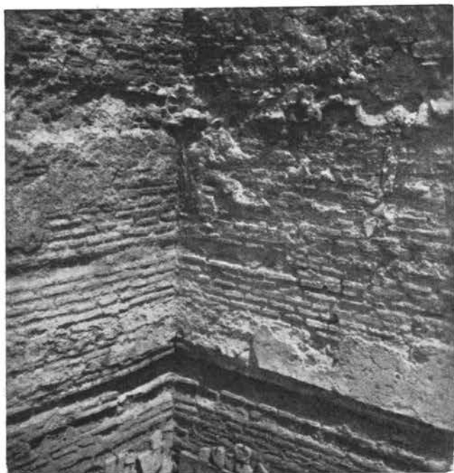
Fig. 60 — S. BALBINA. — Angolo tra l'abside (a sinistra) e il muro di fondo (a destra).
